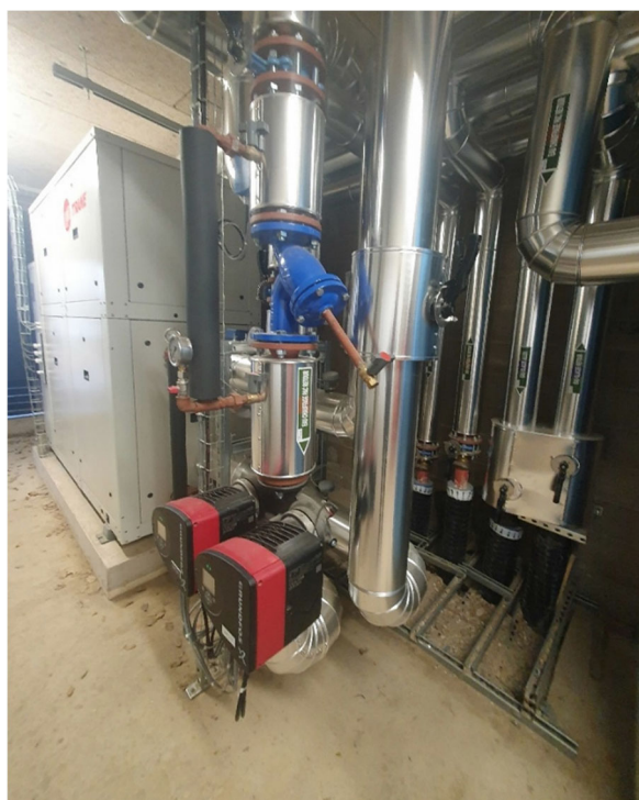
une PAC et ses raccordements
