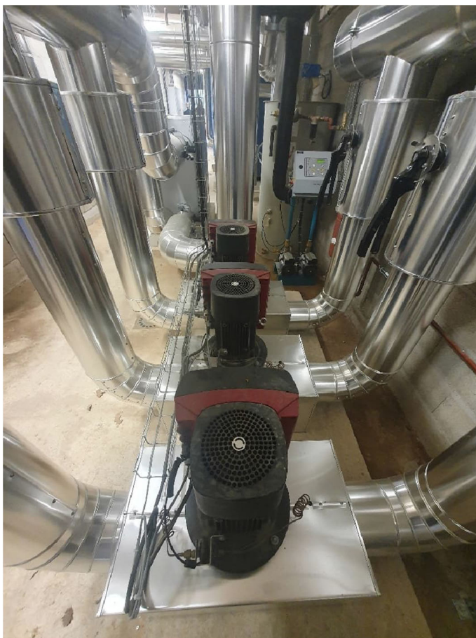
les 3 pompes de circulation de la BET située dans le local atelier.
