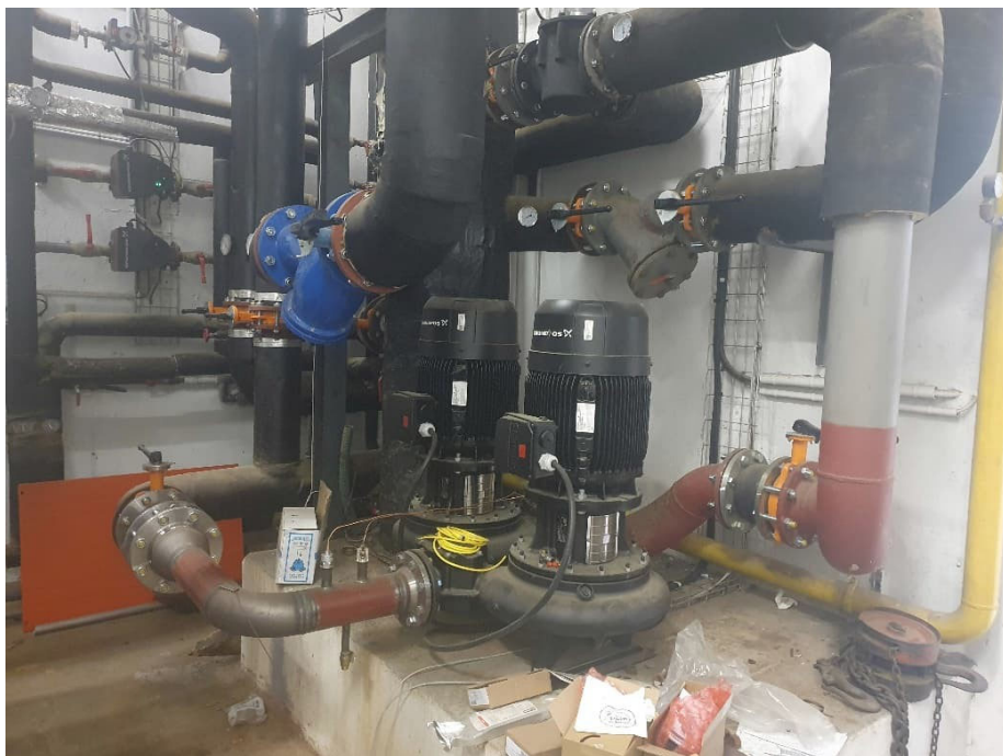
pompes d'alimentation de l'ancien réseau de chaleur
