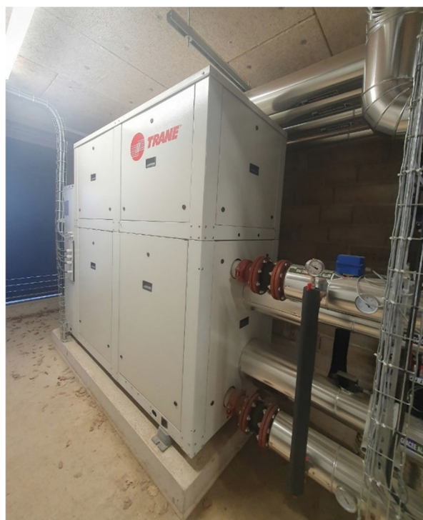
une PAC et ses raccordements
